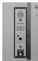
非常通報装置の例
