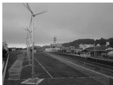
鉄道駅構内における風力発電
