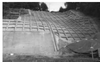
斜面の補強
