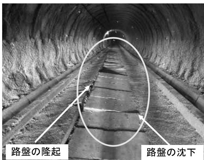
トンネル（先進導坑）の変状
