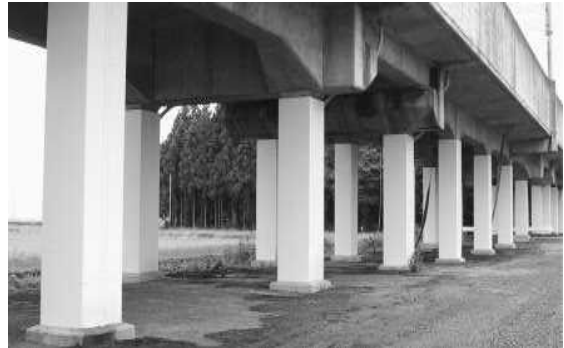
鋼板巻きによる高架橋の耐震補強
