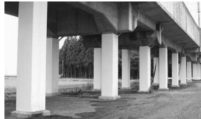
鋼板巻きによる 高架橋の耐震補強
