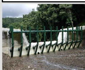
流木捕捉工の追加設置(多機能化)
