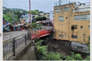
逢初橋付近の土石流被害(静岡県提供)
