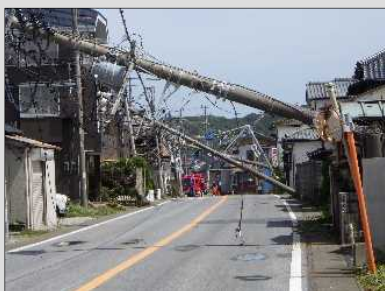
< 令和元年房総半島台風による被害 >
