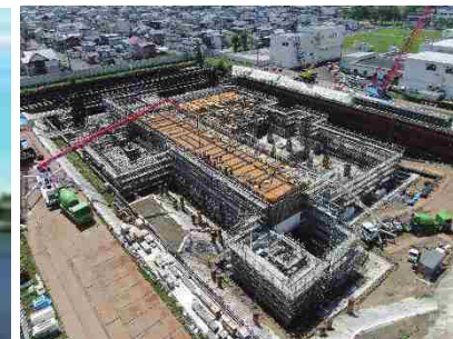
新浄水場施工状況 写真提供：釧路市
