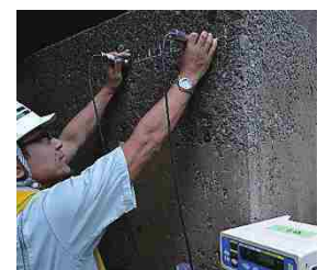
非破壊試験(表面走査法)による凍害点検
