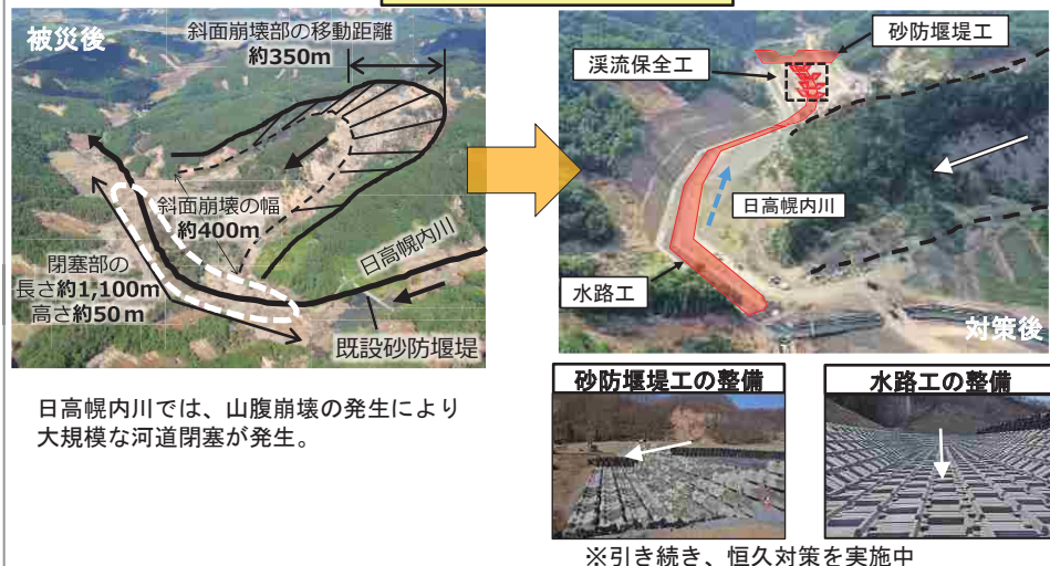
日高幌内川における対策工
