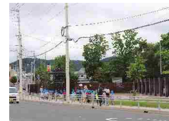
交通安全対策：防護柵
