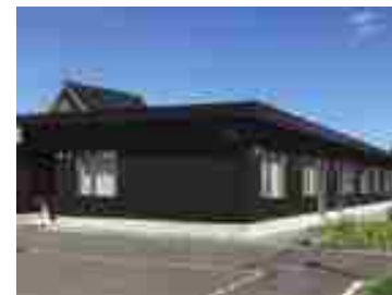
道産材を活用した道営住宅(余市町)
