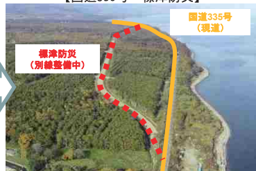
【国道335号 標津防災】
