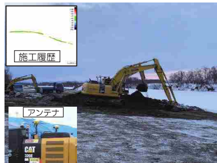
施工履歴を用いたICT施工
