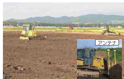
GPSを活用した整地工の状況
