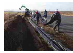
角型多条電線管の試験施工 （寒地土木研究所 苫小牧寒地試験道路）
