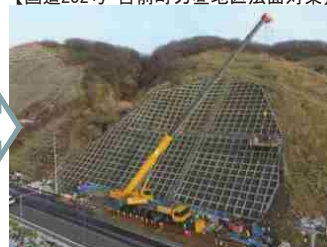
【国道232号 苫前町力屋地区法面対策】
