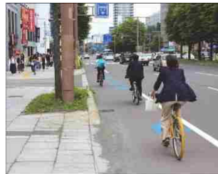
自転車の通行位置を示す矢羽根型路面表示の設置例 一般国道230号(札幌市)
