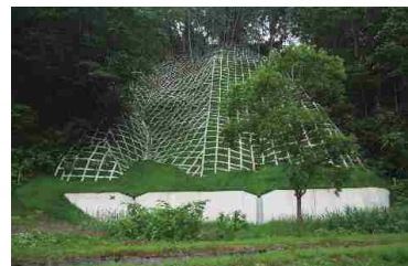
斜面の安定を図る山腹工
