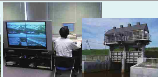
【樋門遠隔操作化(新釧路川)】 津波発生時の迅速な閉扉操作により、津波による浸水被害軽減効果が期待。
