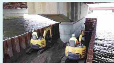
【橋梁の耐震補強(国道38号釧路大橋)】 地震後、橋としての機能を速やかに回復でき支障ルートや避難ルートとして活用が可能。
