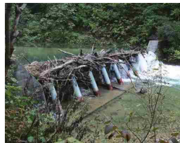
流木捕捉機能を持った治山ダム
