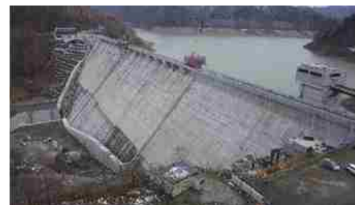
工事中の新桂沢ダム（三笠市）
