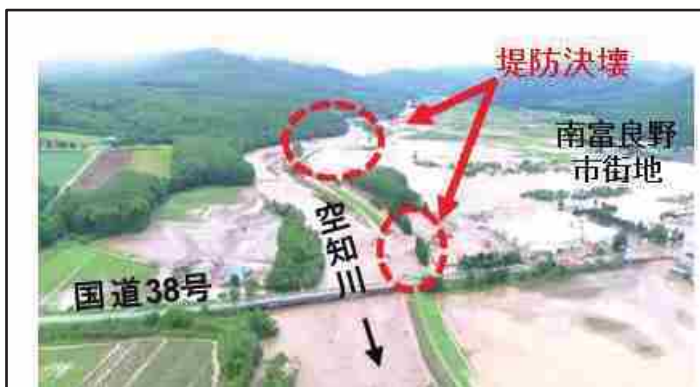
空知川の被災状況
