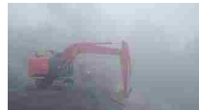
濃霧条件下でのICT施工状況
