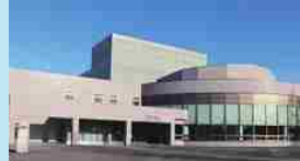
防災設備の改修（中標津町）
