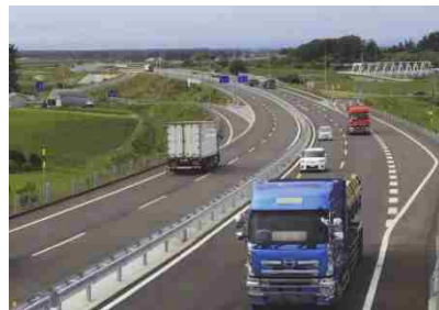
※北海道開発局調べ 一般国道337号 道央圏連絡道路 泉郷道路
