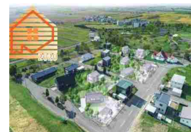
北方型住宅の建設が進む分譲地(南幌町)
