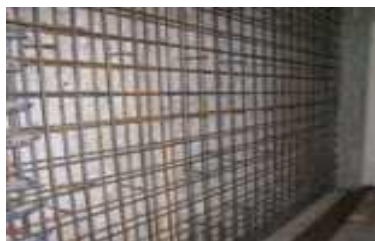
耐震壁増し打ち
