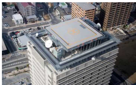
屋上ヘリポート
