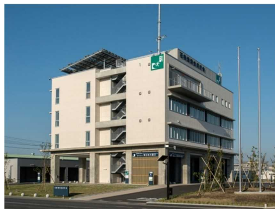
【津波対策を実施した官庁施設の例 (石巻港湾合同庁舎)】
