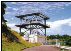
遠隔対空通信施設
