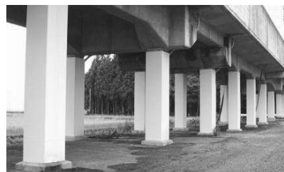
鋼板巻きによる 高架橋の耐震補強
