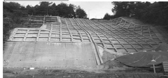
コンクリート枠による斜面の補強
