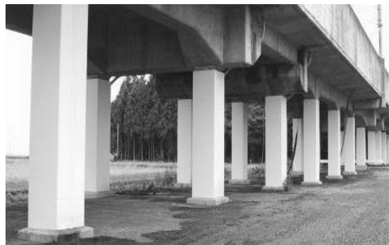
鋼板巻きによる高架橋の耐震補強
