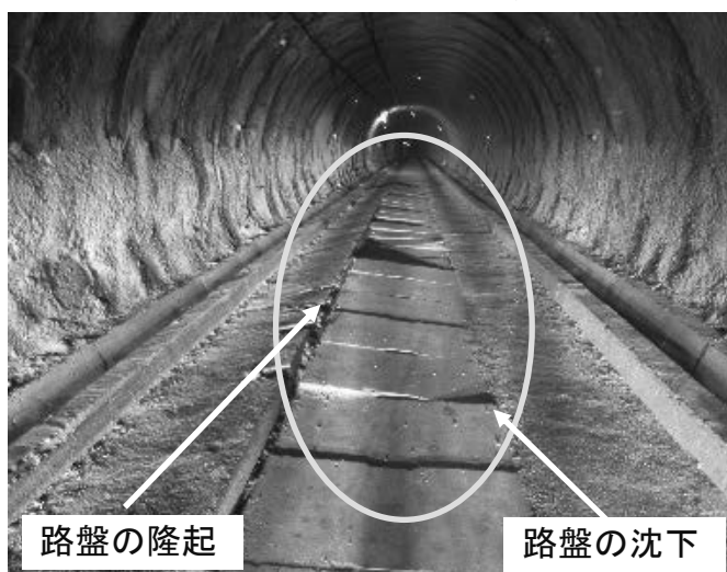
トンネル（先進導坑）の変状
