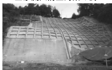
斜面の補強
