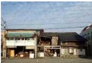
＜空き家の除却事例＞
