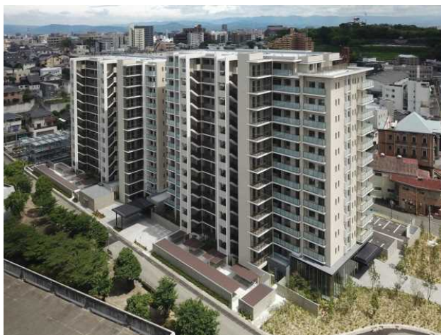
熊本市 上熊本地区優良建築物等整備事業
