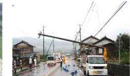
沿道の電柱の倒壊による道路閉塞
