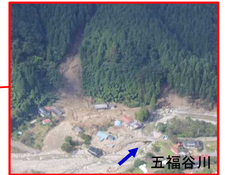
山腹崩壊発生状況
