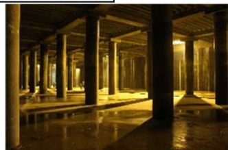
大規模地下貯留施設
