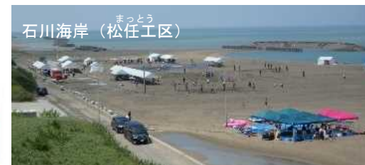
直轄事業で侵食対策として整備した、石川海岸(松任工区)の砂浜を海岸保全施設として指定。
