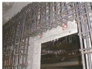
処理場の耐震化(躯体補強)
