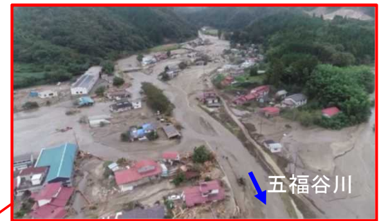
土砂・洪水氾濫状況
