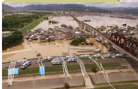
【H30.7月豪雨】 (岡山県倉敷市真備町)
