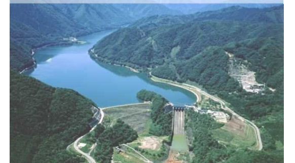
牧尾ダム(水資源機構: 農業・水道・工業用水道・発電)
