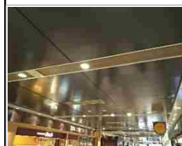
天井板の耐震改修
