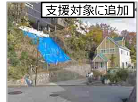
切土斜面の危険度調査等
