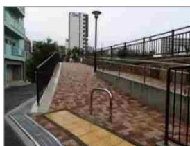
車いす利用者等の移動に配慮し階段をスロープに改修
