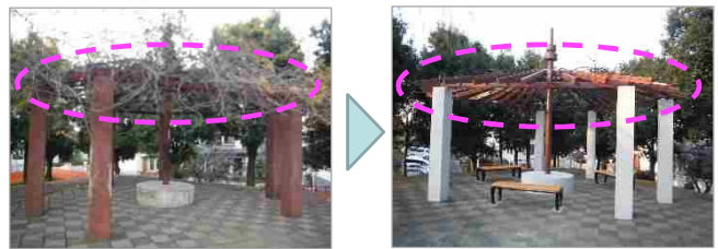
老朽化したパーゴラの梁等の交換
