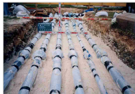
連結送水管（配管理設イメージ）
