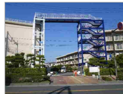
既存施設(市営住宅)への避難階段設置
