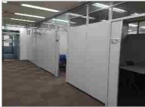
仕切り壁の設置
