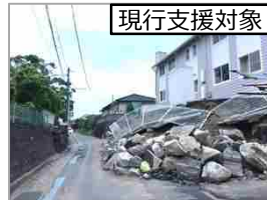
宅地擁壁等の危険度調査等
