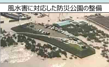
国営公園等事業 都市公園防災事業 都市公園・緑地等事業
