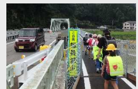
仮橋の設置が完了した西瀬橋を利用して通学する児童
