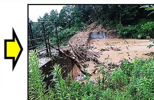
【令和2年7月豪雨】砂防堰堤が土砂と流木を捕捉
