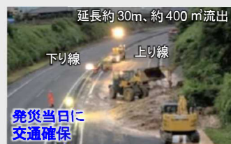
【大分自動車道 九重IC～湯布院IC】 九重IC～湯布院IC間の上り線で路肩崩壊が発生し、並行する国道210号も同時に被災。一時交通が寸断されたものの、大分自動車道の下り線を対面通行として活用することで、発災4日後に広域交通を確保
