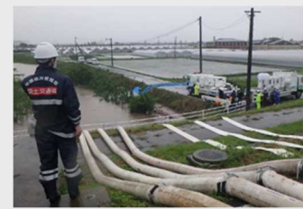
排水ポンプ車による緊急排水状況 【福岡県久留米市】
