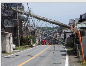
＜令和元年房総半島台風による被害＞
