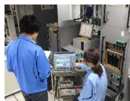
(航空保安施設点検実施状況)
