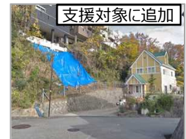
切土斜面の危険度調査等
