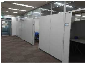
仕切り壁の設置
