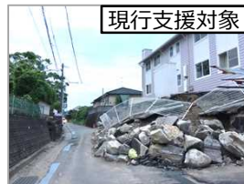
宅地擁壁等の危険度調査等
