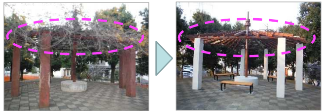
老朽化したパーゴラの梁等の交換
