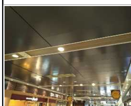
天井板の耐震改修
