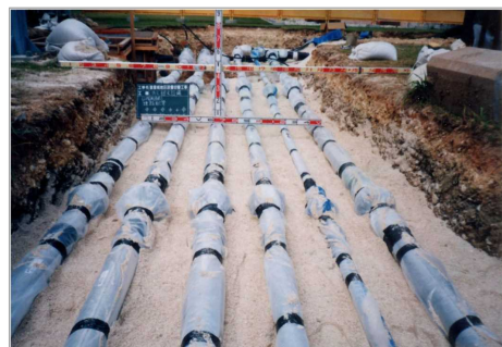
連結送水管（配管理設イメージ）
