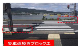
歩車道境界ブロック工
