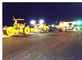
(老朽化した滑走路舗装の改良)
