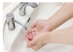
衛生設備の非接触化
