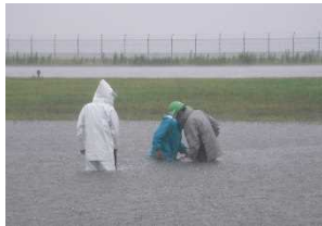
(着陸帯の冠水状況)
