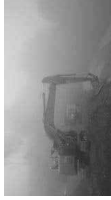
濃霧条件下での施工状況
