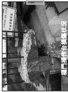
橋台損傷状況
