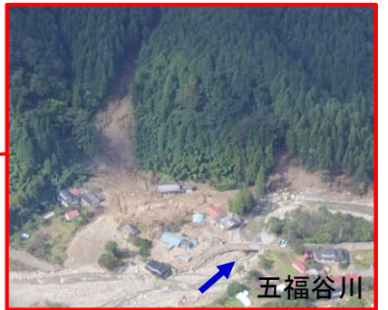
山腹崩壊発生状況
