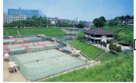
雨水貯留浸透施設の例(防災調整池)
