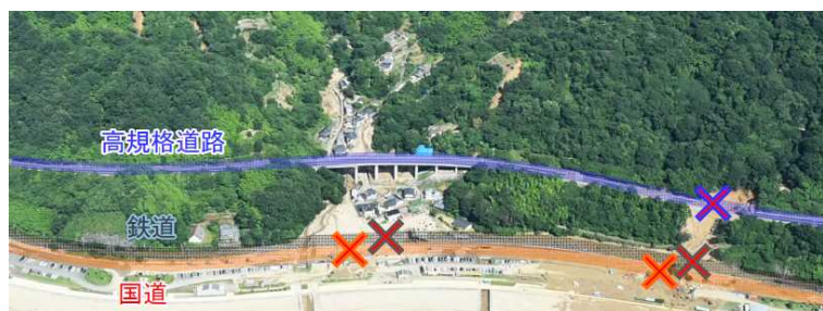
交通インフラの被災状況(広島県安芸郡坂町)
