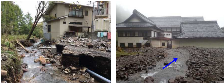
新鹿沢温泉における土砂災害被害(群馬県吾妻郡嬭恋村)
