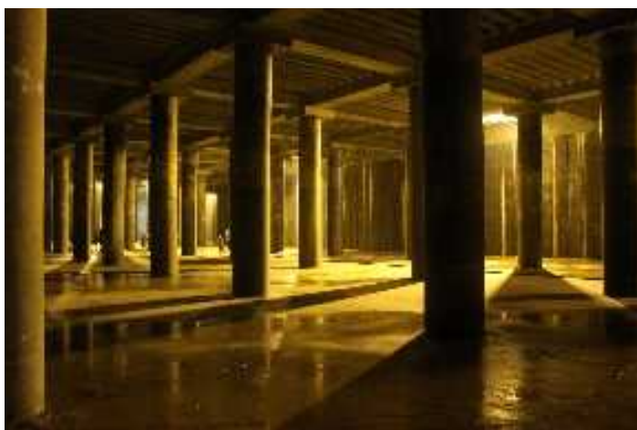
大規模地下貯留施設
