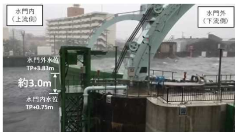
平成30年台風第21号による高潮から市街地を守る木津川水門(平成30年9月4日)
