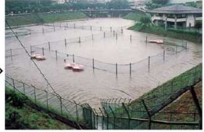
雨水貯留浸透施設の例(防災調整池)
