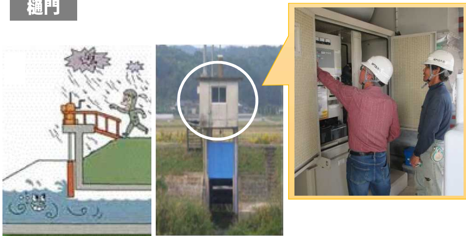
引上式ゲート(操作員による扉の開閉が必要)
