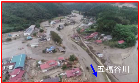
土砂・洪水氾濫状況
