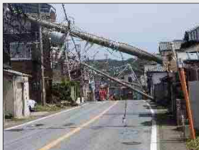
< 令和元年台風 15 号による被害 >
