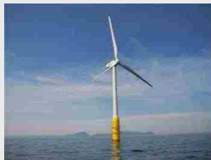
洋上風力発電によるエネルギーの地産地消(長崎県五島市) 写真提供: 五島市
