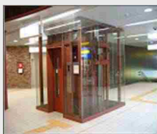
鉄道駅等における段差解消
