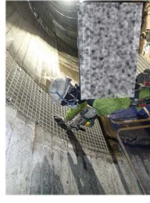
修繕の様子(剥落対策)
