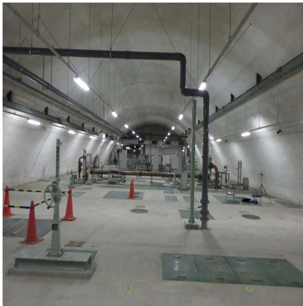
写真1 浄化センター第4系列の機械電気設備増設箇所
