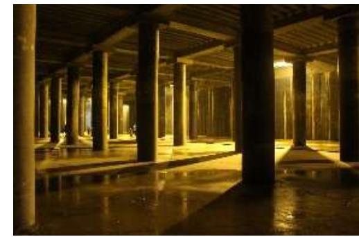
貯留施設の整備
