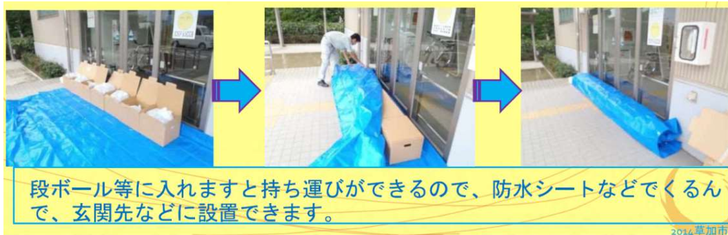
簡易「水のう」の設置例
