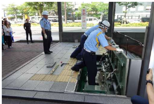
手動起上式止水板設置
