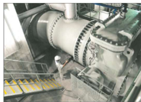
雨水ポンプの整備
