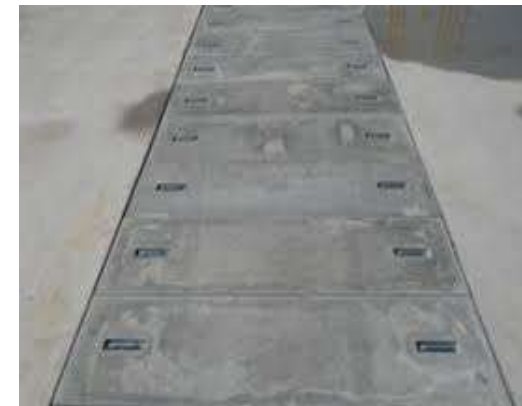
コンクリート製の覆蓋への変更
