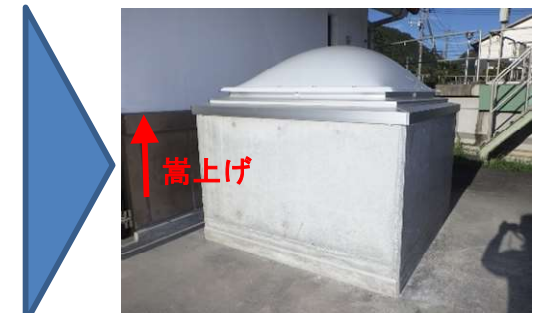
トプライトの止水対策 (左:実施前 右:実施後)
