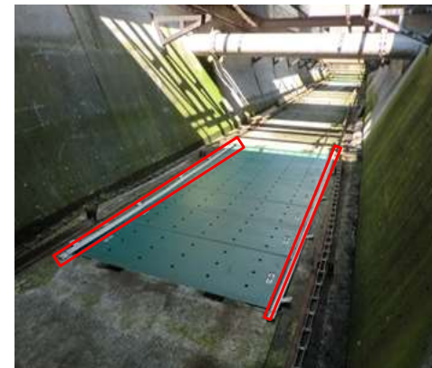
飛散防止金具の設置
