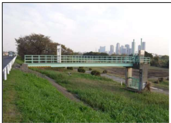
堤外側でゲート进行操作する樋門
