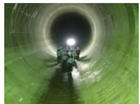
雨水貯留管の整備
