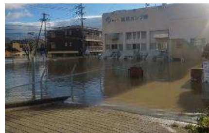
ポンプ場浸水状況
