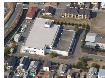
当新田ポンプ場 平成28年3月 305m 3 /min増強 排水能力 955m 3 /min
