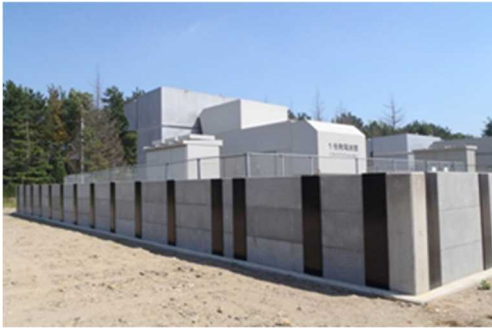
防水壁の設置
