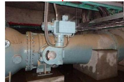
被災したポンプ吐出弁電動機
