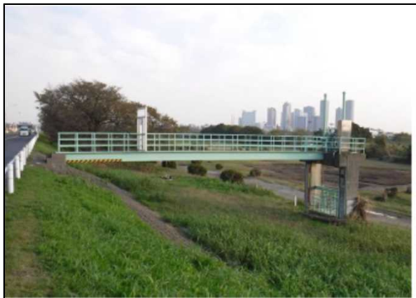
堤外側でゲート进行操作する水門
