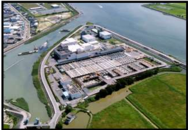
流域下水道 境川浄化センター（刈谷市）
