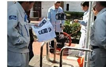
(管渠調査の様子)
