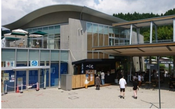
水源地域振興施設「道の駅したら」
