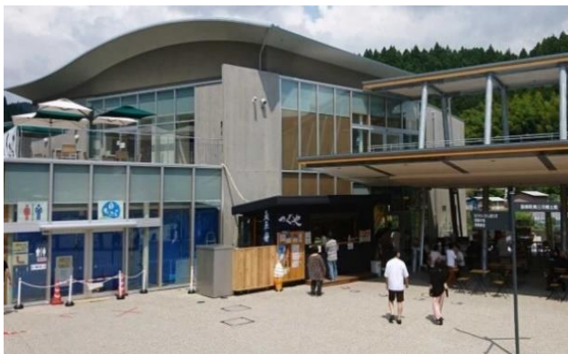
水源地域振興施設「道の駅したら」
