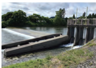
●稲生川取水口
