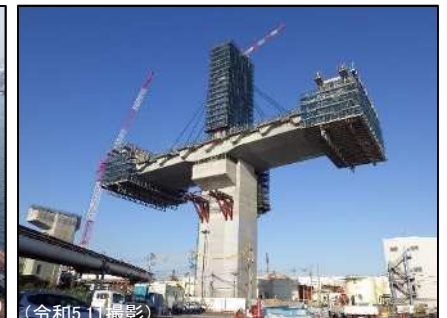
③橋脚MP5,6
