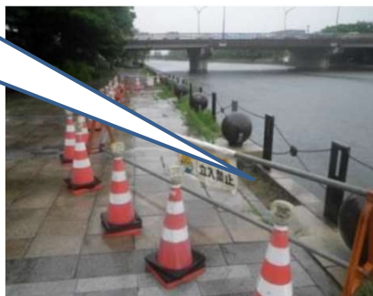
※鋼矢板開口部からの裏埋土砂流出が原因
