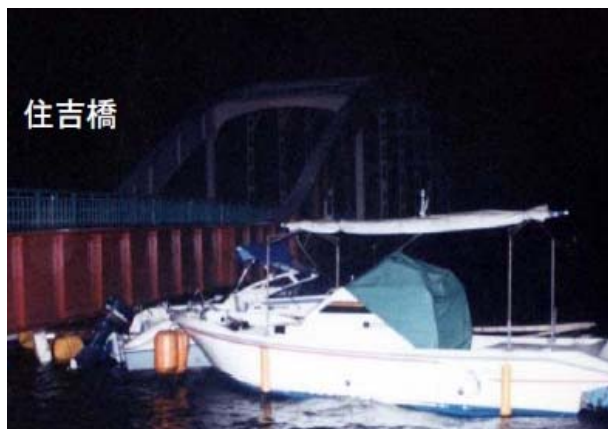
流出した不法係留船が橋梁に激突、流下障害
