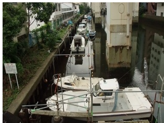
狭隘な河川内に係留され、流下障害
