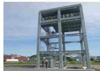
津波避難タワー(船川港)
