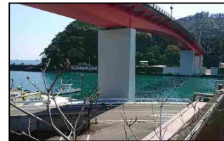
長島港 (橋梁の改良)
