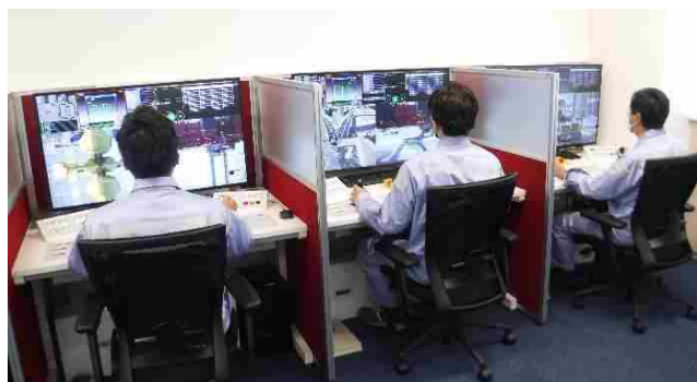
遠隔操作室内のオペレーター
