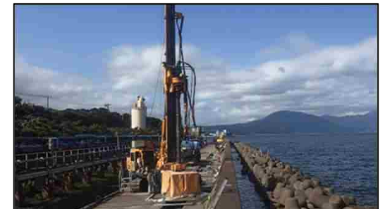
護岸の耐震・液状化対策(大分港海岸)
