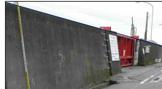
高潮等から市街地を防護する胸壁(嵩上げ・耐震化予定) (千葉港海岸)
