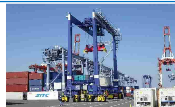
遠隔操作RTG
