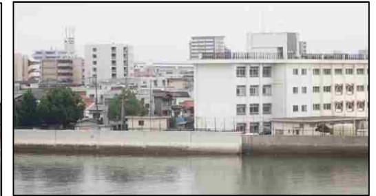
高潮等から市街地を防護する護岸 (広島港海岸)
