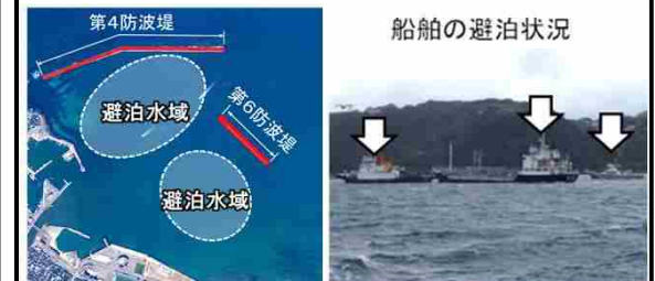
防波堤の整備(輪島港) 防波堤内に避泊する船舶(下田港)
