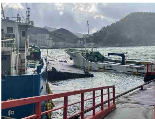
棧橋の被災[宇和島港(愛媛県)]
