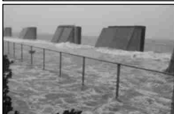
高波で浸水した フェリーターミナル
