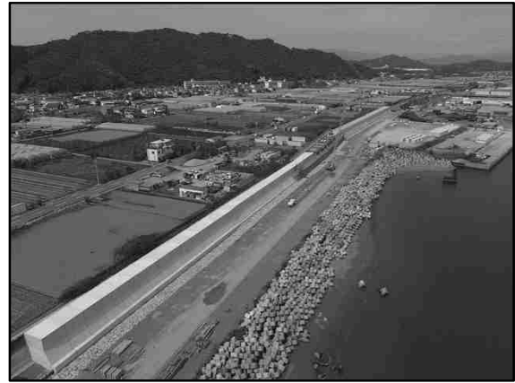
粘り強い構造の堤防整備（高知港海岸）
