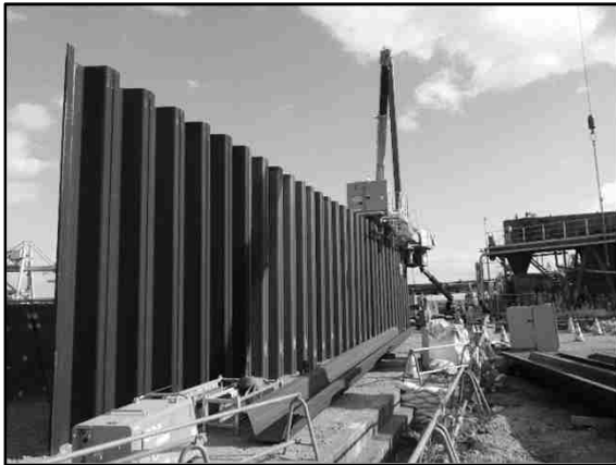
護岸の耐震・液状化対策（大分港海岸）
