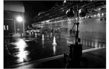
船内通信用ケーブルの敷設工事の支援
