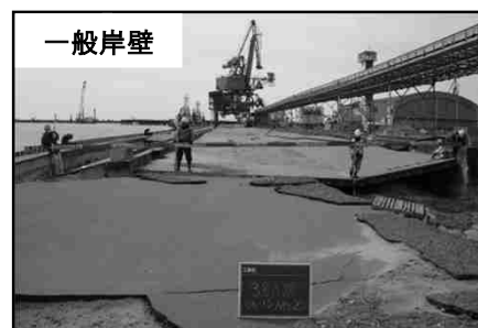
東日本大震災における耐震強化岸壁と一般岸壁の被災状況 (小名浜港)
