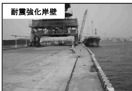
東日本大震災における耐震強化岸壁と一般岸壁の被災状況 (小名浜港)
