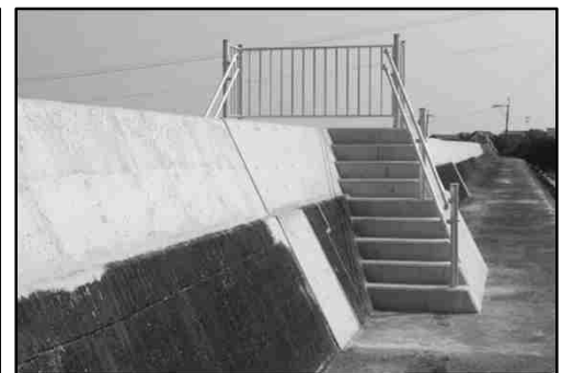
陸閘を廃止し通行用の階段を設置 （中津港海岸）
