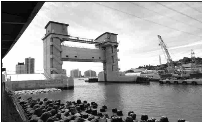
津波から市街地を防護する水門 (和歌山下津港海岸)
