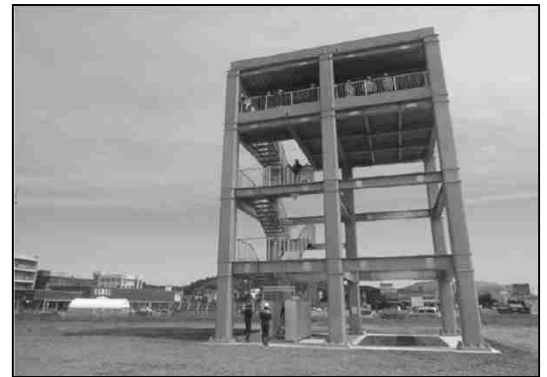
津波避難タワー（船川港）
