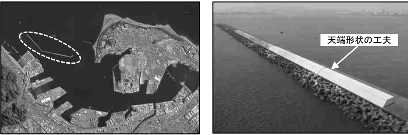
粘り強い構造の防波堤（清水港）
