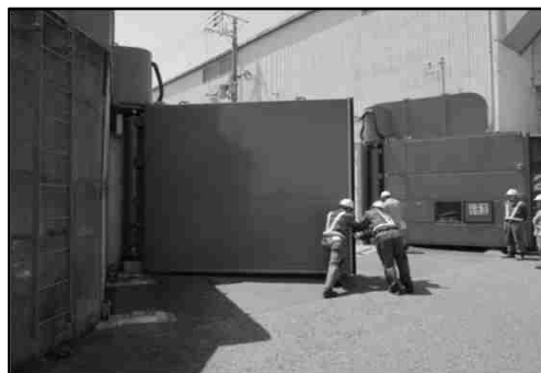
平常時の点検・訓練 （大阪港海岸）
