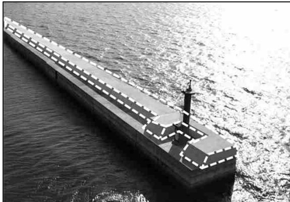
津波対策として防波堤嵩上げ(湯浅広港)
