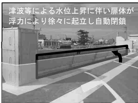
フラップゲート式の陸閘 （津松阪港海岸）
