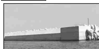
上部工の嵩上げ
