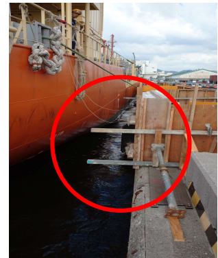
工事につき、障害物が多数
