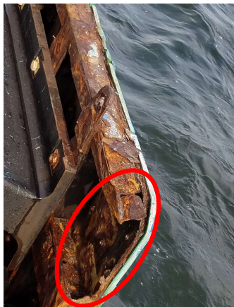
防舷材の経年劣化 ②
