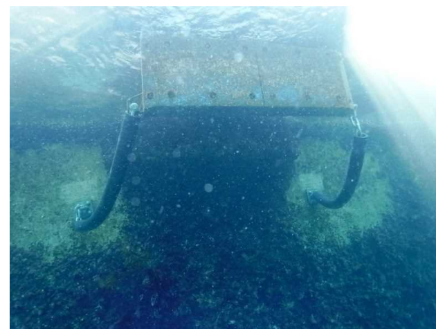
潜り込み対策(チェーン)付きの 受衝板付き防舷材の設置
