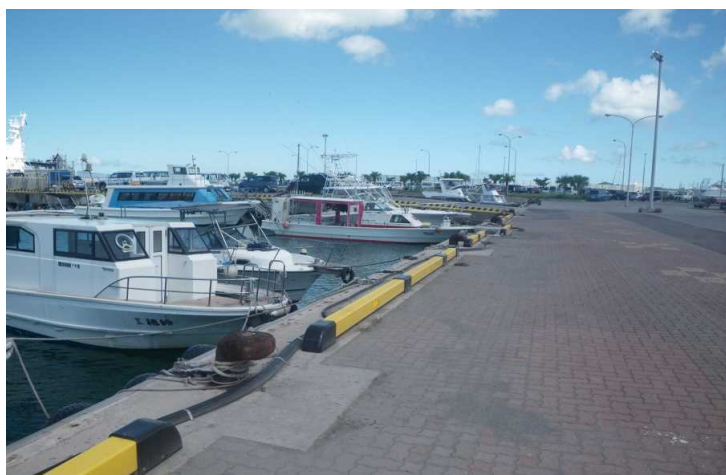
係船柱より陸側に車止めを配置
