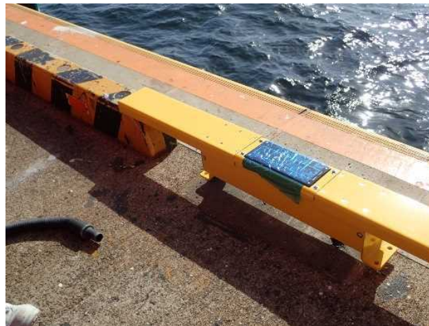
車止めと一体化した接岸灯の設置
