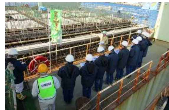
地元高校生による現場見学会の様子
