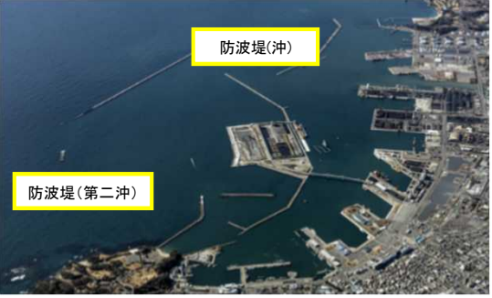
整備中の防波堤(沖)及び防波堤(第二沖)全景
