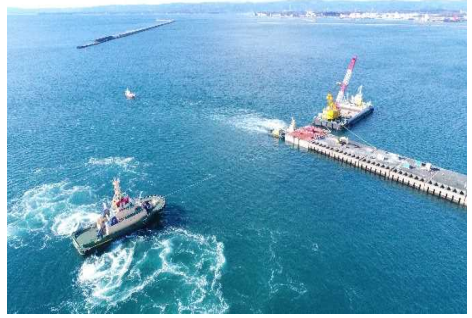
防波堤整備の様子(ケーソン据付)
