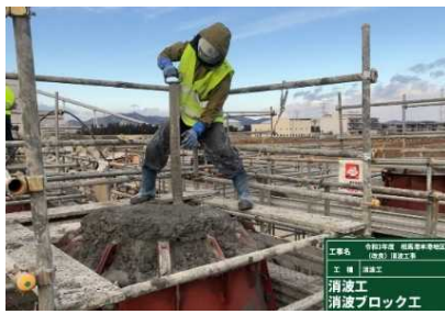
ブロック製作状況
