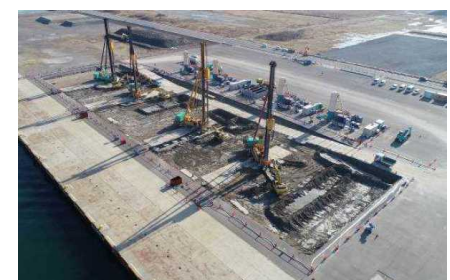
地盤改良工事(地耐力強化)
