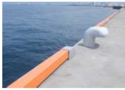
老朽化対策後
