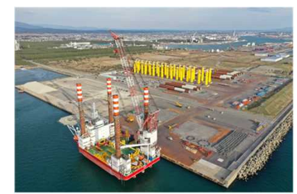
基礎構造部材のヤード使用状況
