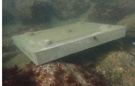
海底にブロックを設置した様子
