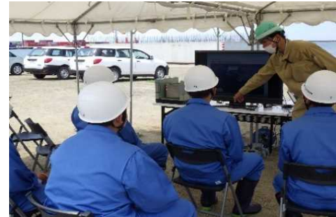
港内見学・工事現場見学の様子('22.5.23)
