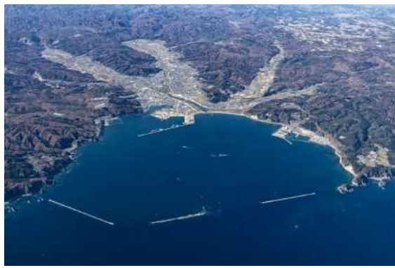
整備中の湾口防波堤全景
