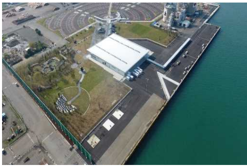
令和2年3月に耐震強化岸壁が完成
