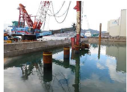
鋼管杭打設の様子
