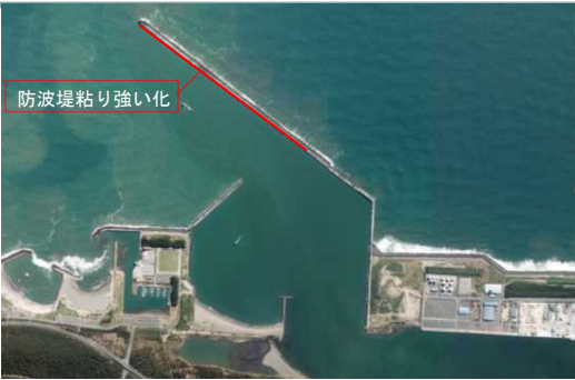
宮崎港防波堤
