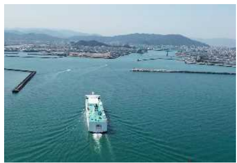
改良が進む防波堤
