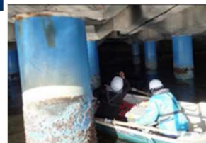
小型船等による施設点検 (写真提供：港湾空港技術研究所)
