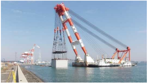
整備中(耐震強化岸壁)
