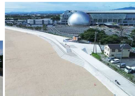
阿漕浦・御殿場工区整備後
