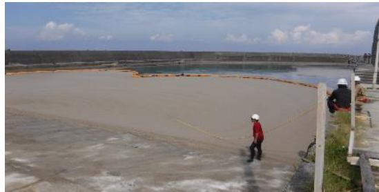
(写真2) シルトフェンスで集積する様子
