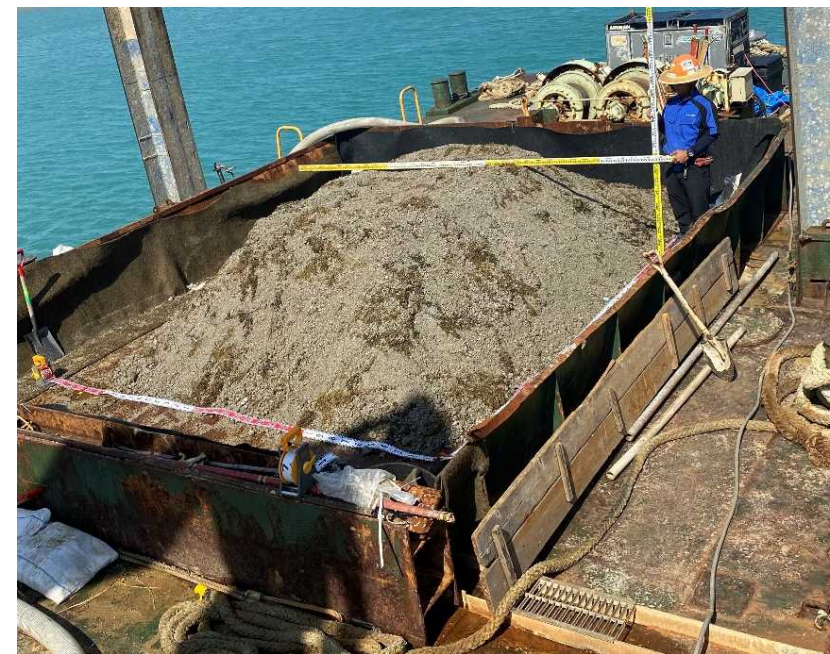
回収状況（コーミング 6.0m x 4.9m x 0.6m）
