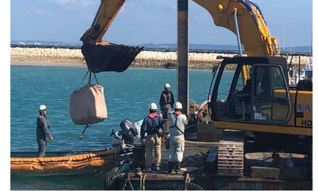
バックホウによるトン袋回収状況
