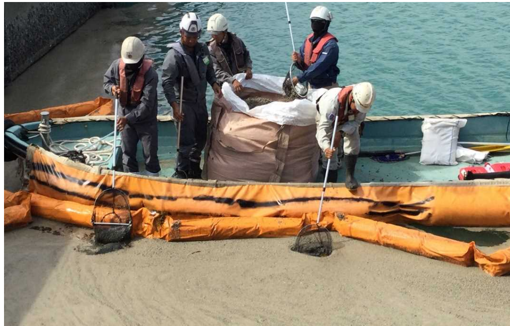
タモ網による軽石回収作業
