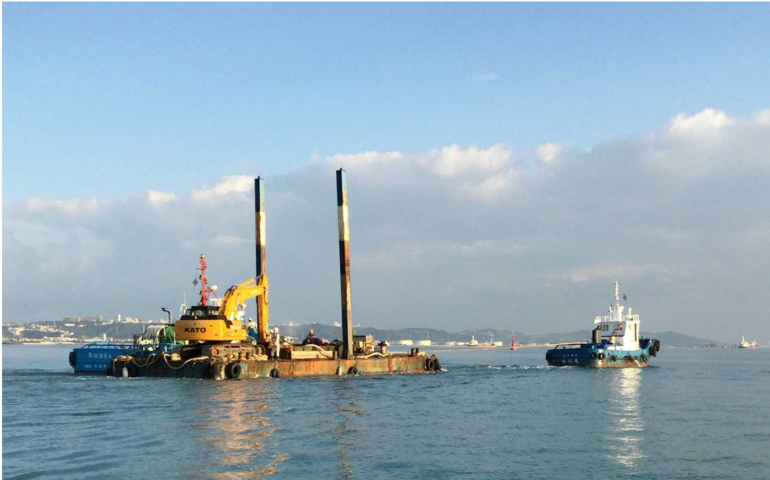
曳船2隻体制による曳航作業（被曳航中の曳船は台船に固縛）
