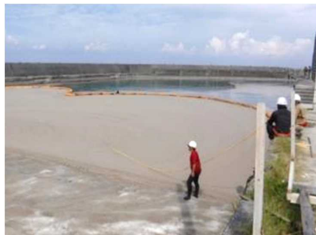
参考写真②-2: シルトフェンスでの軽石の集積
