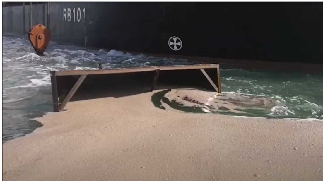
参考写真①：サンドポンプによる吸引状況
