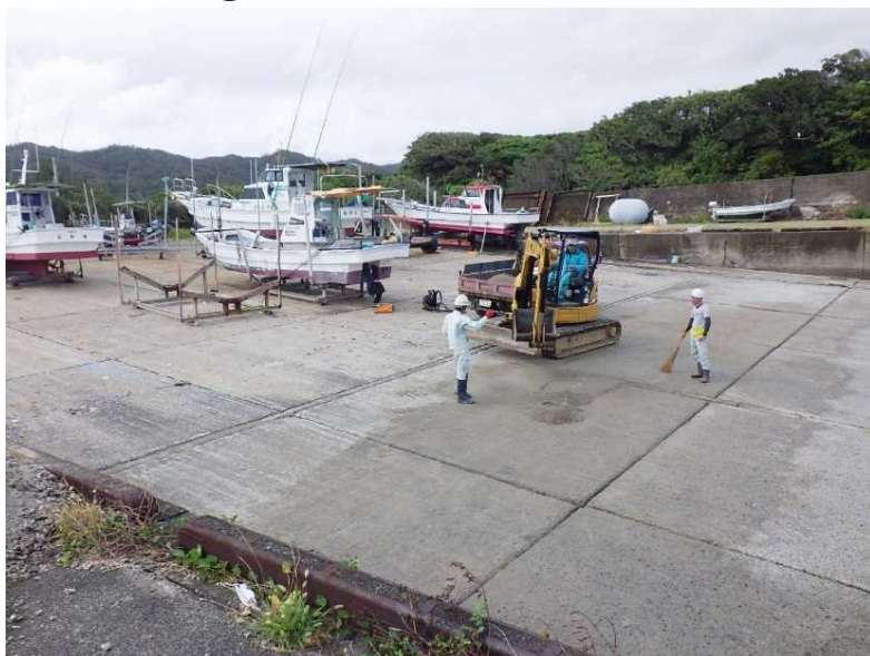
参考写真②: 軽石回収状況
