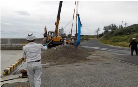
参考写真②:クレーンで陸揚げ後、ホイールローダーで運搬する様子
