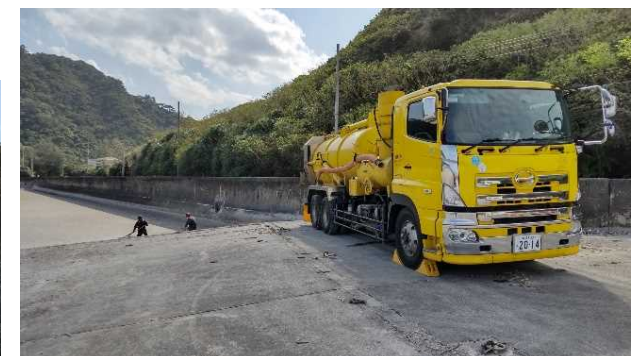
資機材配置状況
