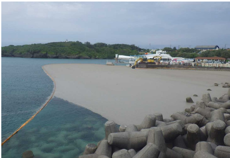
参考写真①: オイルフェンスの展張状況
