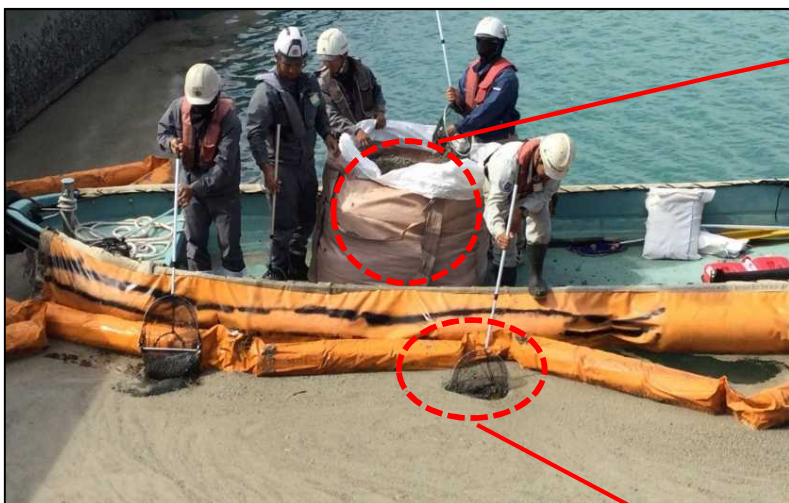
参考写真②: タモ網及び回収作業の状況
