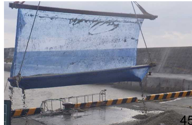
参考写真①-1: 防風ネットから作成した網
