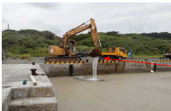
参考写真③:バックホウによる回収の状況
