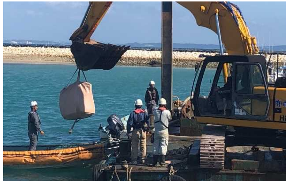
参考写真③: バックホウによるトン袋回収
