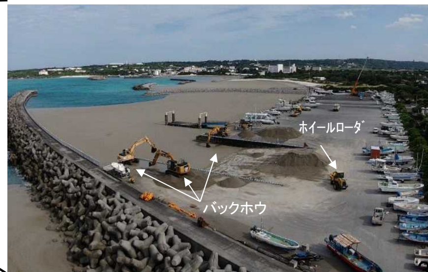
撤去状況(11月5日撮影)
