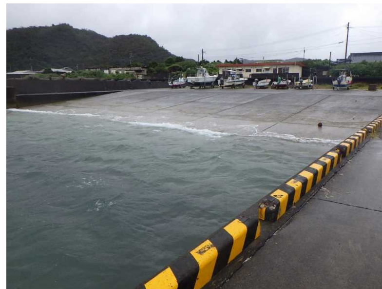
参考写真③: 作業完了
