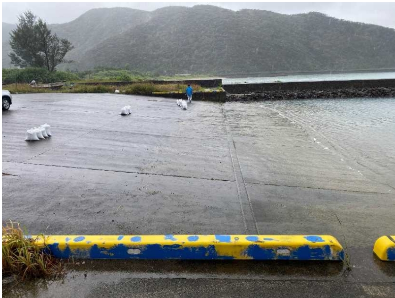
参考写真②: 作業経過
