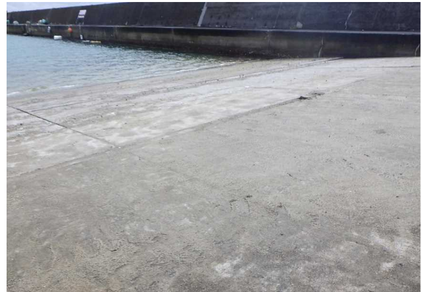
参考写真③: 作業完了
