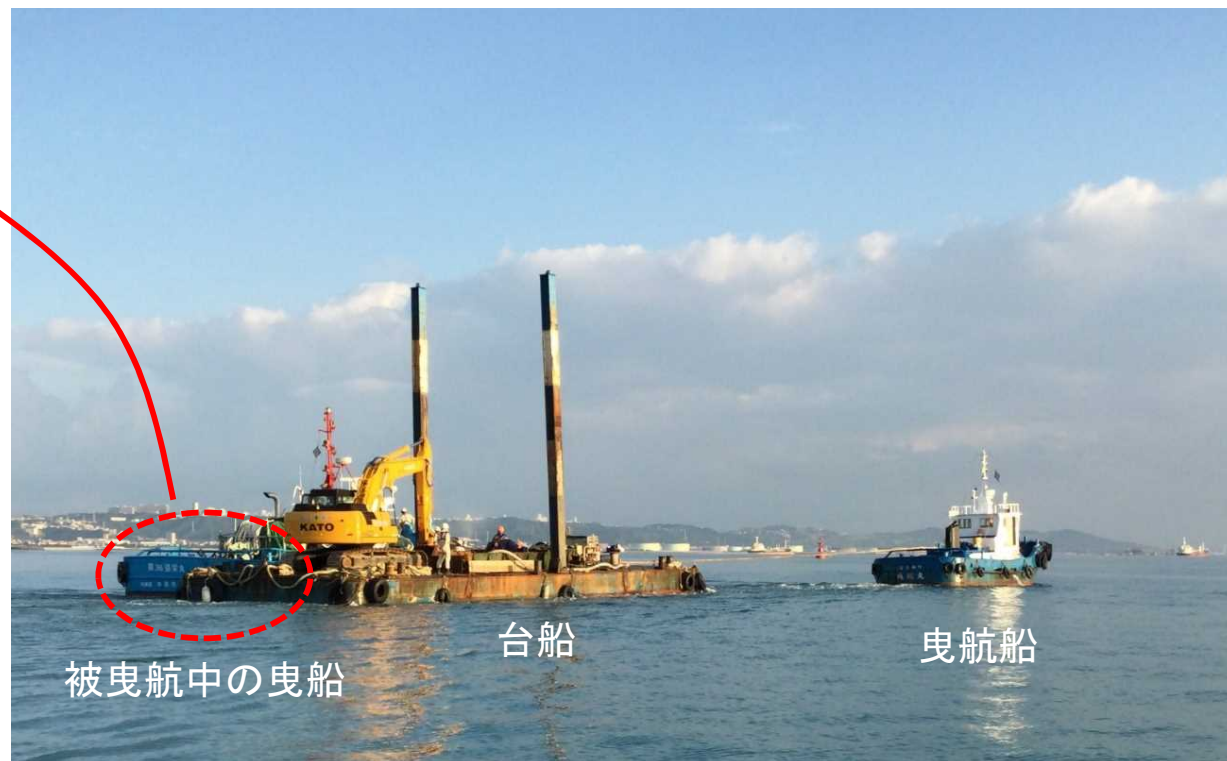
曳船2隻体制による曳航作業(被曳航中の曳船は台船に固縛)
