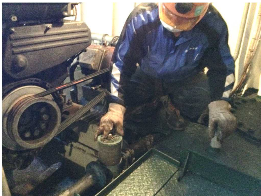
被曳航中の海水フィルター清掃作業手順等確認状況
