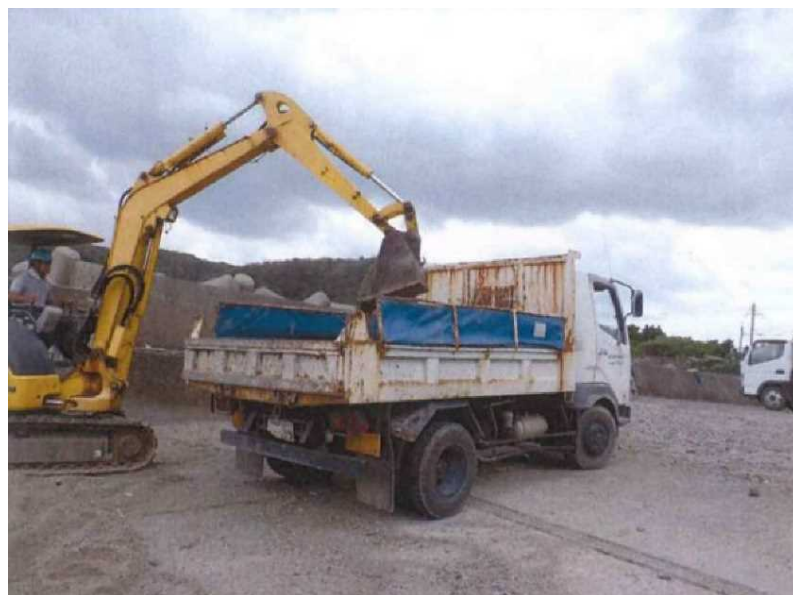
参考写真②: 軽石回収状況
