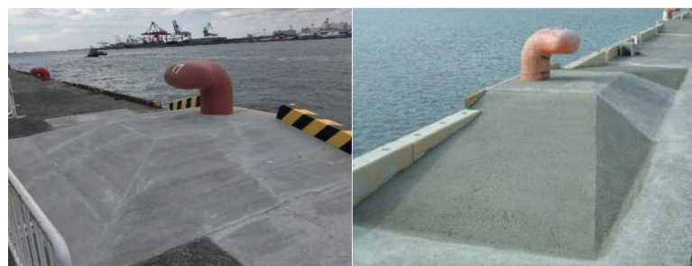
係船柱大型化に伴う上部工嵩上げ事例
