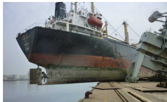
船舶の岸壁への乗り上げが発生(仙台塩釜港)
