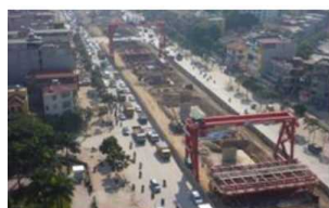
写真-6 下部工 施工状況
