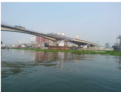
(写真) 送出し架設の様子(IHIインフラシステム提供、以下同じ)
