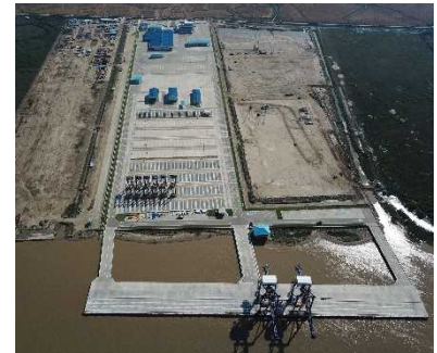
ティラワ港コンテナターミナル現況
