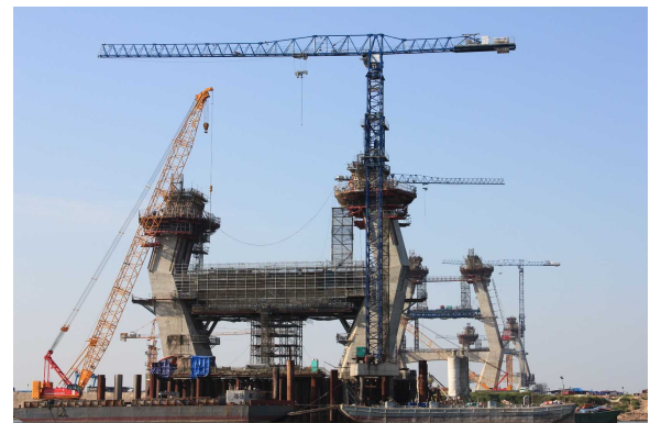
(写真) 自昇降式作業所による主塔の施工 (三井住友建設提供)
