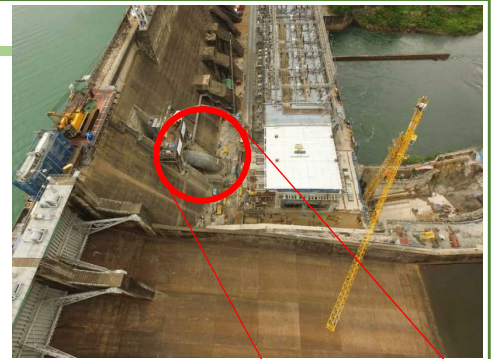
(写真) 穿孔を横から見た（安藤・間提供）
