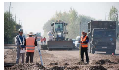
(写真) 現場での型枠、道路舗装OJT (大日本土木提供)
