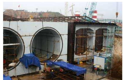
(写真) 沈埋函 (大成建設提供)
