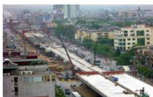
写真-7 上部工 施工状況
