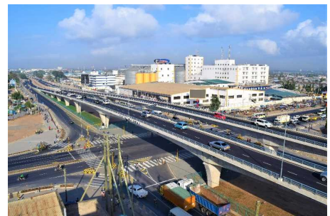
(写真) 完成したタザラ交差点（三井住友建設提供）
