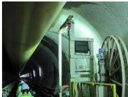
(写真) 導水トンネル
