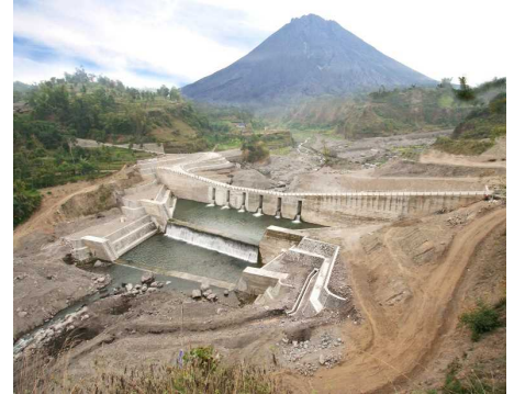
(写真) 砂防ダム (清水建設提供)
