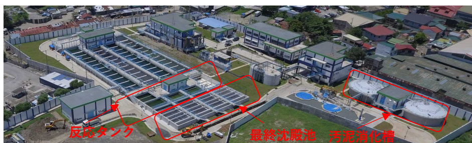
(写真) 完成時全景 (JFEエンジニアリング提供)
