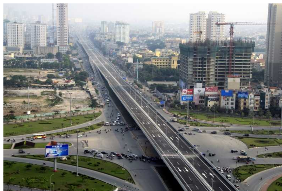
(写真) 竣工したリングロード高架橋全景 (三井住友建設提供)
