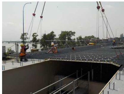
(写真) 合成床板架設の様子
