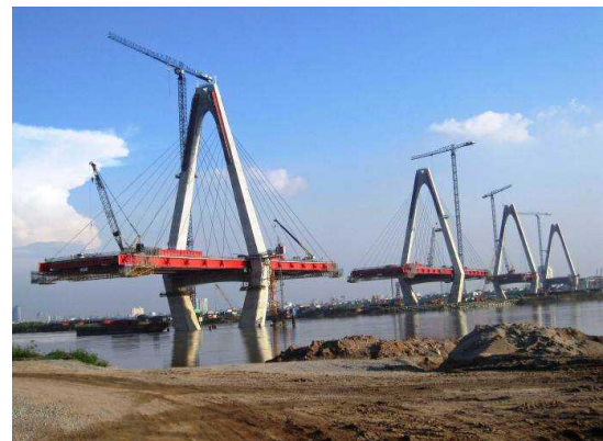
(写真) 完全バランス架設 (IHIインフラシステム提供)
