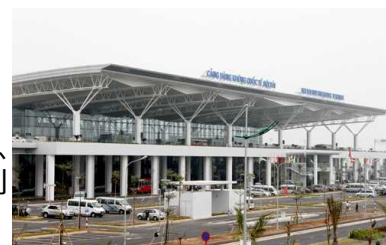
(写真) 竣工したノイバイ国際空港第2旅客ターミナルビル全景 (大成建設提供)
