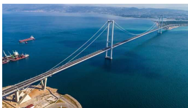
(写真) オスマン・ガーズィー橋全景 (IHIインフラシステム提供)
