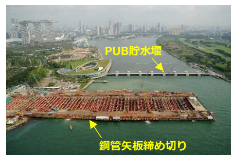
(写真) マリーナ地区高速道路C485工事の様子 (五洋建設提供)
