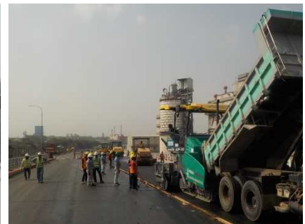
(写真) PMB舗装の様子
