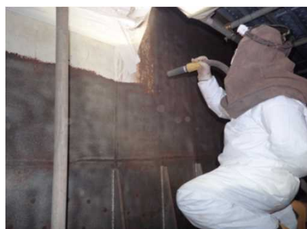
(写真) ブラスト施工をしている状況 (大林組提供)
