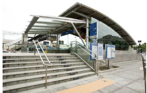
(写真) バンコクメトロの入口 (久野真一/JICA提供)
