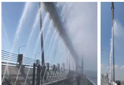
(写真) 水冷却システム
