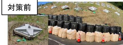
アンカーの変状 (ズレ・沈下・隙間)
