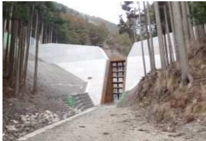
日野谷川堰堤（甲賀市）
