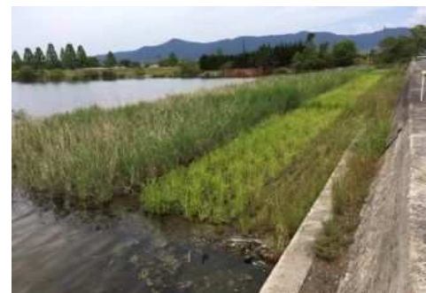
底質改善対策（覆土工・植生工）
