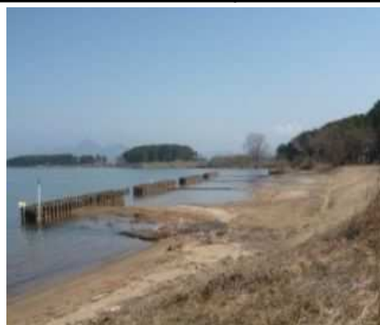
ヨシ群落造成工事実施箇所 （野洲市菖蒲地区）
