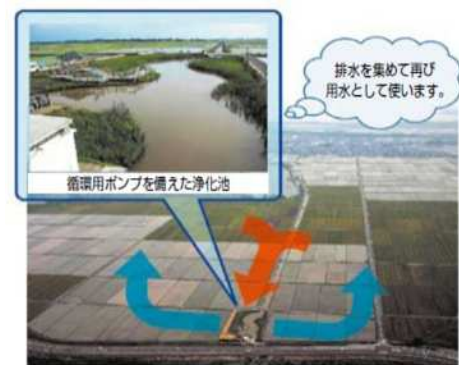
循環かんがい施設(木浜地区)
