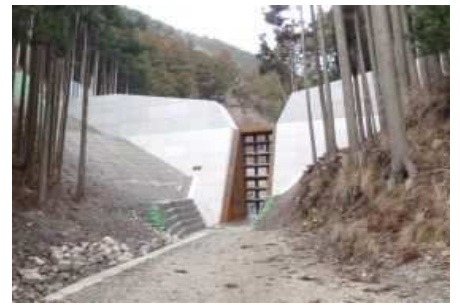
日野谷川堰堤（甲賀市）
