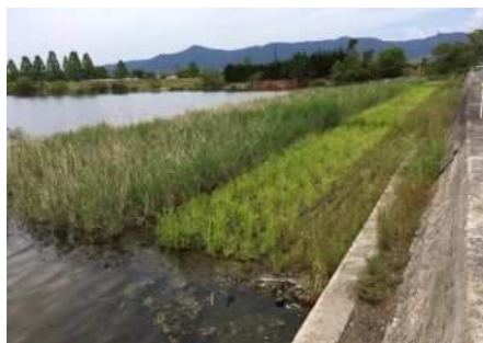
底質改善対策（覆土工・植生工）
