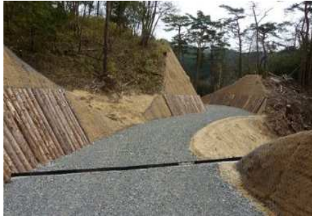
林道支障木を利用した法面保護工（甲賀市）
