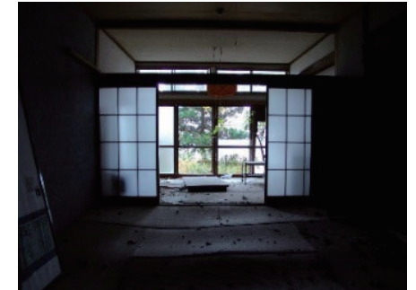
老朽化したホテル・旅館の改修
